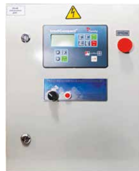
Цифровой пульт управления ДЭС с функцией параллельной работы ДЭС
